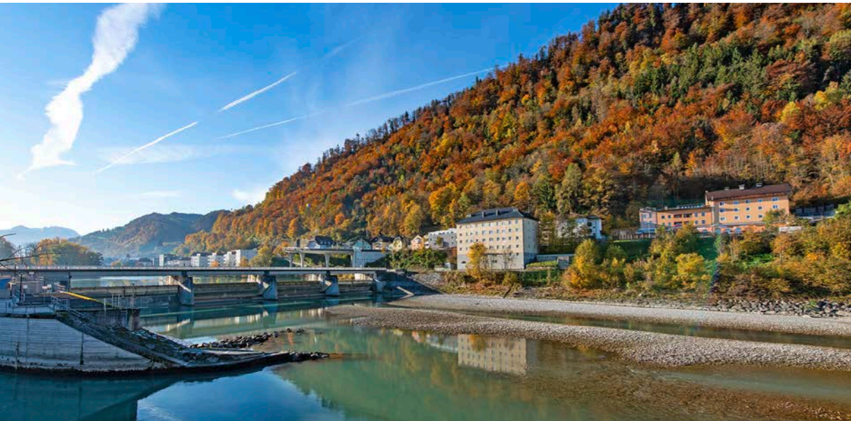
Kraftwerk Sohlstufe Hallein
