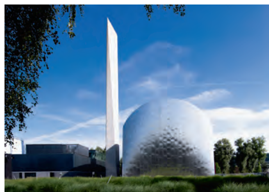
Das Heizkraftwerk Nord ging 1972 für die großen Wohnsiedlungen im Norden Salzburgs in Betrieb und wurde 1995 modernisiert.
