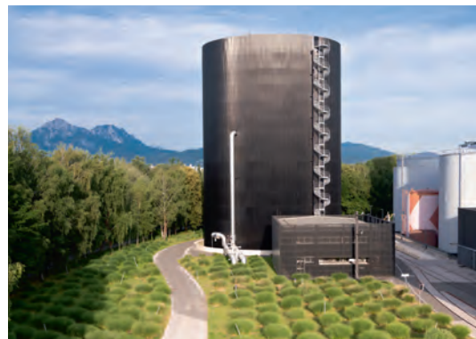
Der 44 Meter hohe Wärmespeicher neben dem Heizkraftwerk Salzburg kann ca. 30 Millionen Liter Heißwasser aufnehmen.
